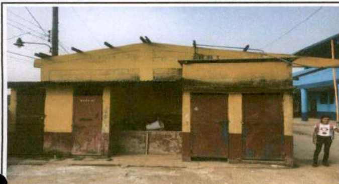
Foto1: MÓDULO 1 AULAS SUSTITUCIÓN DE LÁMINA, POR LÁMINA TROQUELADA ALUZINC CALIBRE 26
