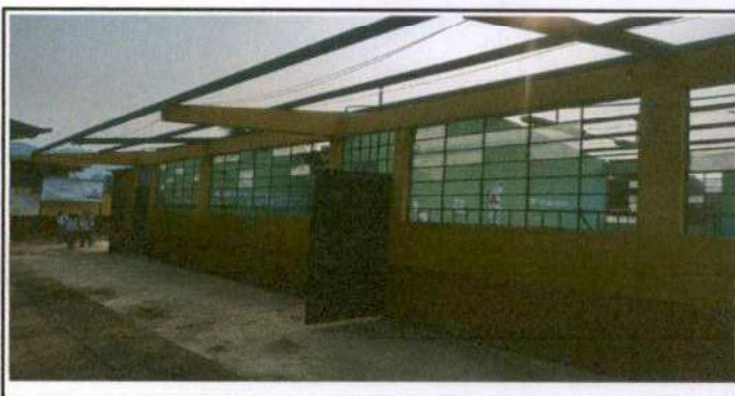
Foto 6: MÓDULO 1 AULAS MANTENIMIENTO A ESTRUCTURA DE METAL
