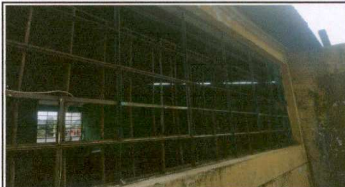
Foto2: MÓDULO 1 AULAS SUSTITUCIÓN DE LÁMINA, POR LÁMINA TROQUELADA ALUZINC CALIBRE 26
