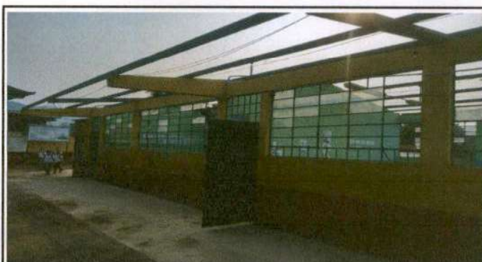
Foto 4: MÓDULO 1 AULAS MANTENIMIENTO A ESTRUCTURA DE METAL
