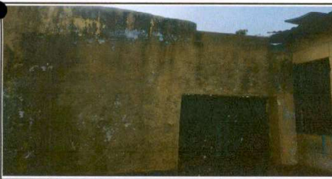
Foto 5: MÓDULO 1 AULAS MANTENIMIENTO A ESTRUCTURA DE METAL
